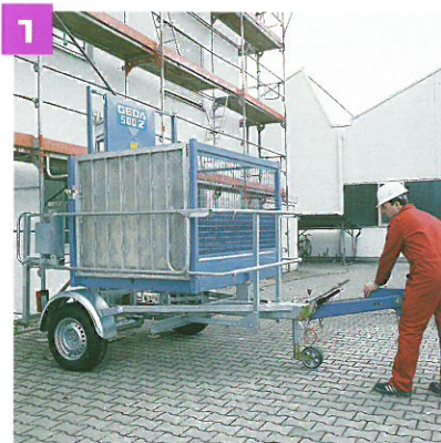
Pomocí homologovaného přívěsu se výtah automaticky vyloží nebo naloží bez pomocného nářadí. Žárově zinkovaný přívěs je tím zároveň chráněn před poškozením a krádeží a může být použit pro další výtahy.
