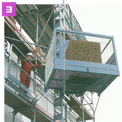
Otáčení nákladní plošiny o 90 stupňů na místě nakládky umožňuje bezpečné překonání volné mezery. Také připojení držáků stožáru z otočné plošiny je velmi snadné. Nakládka dole probíhá souběžně s budovou, což šetří místo, a na úzkém chodníku je často rozhodující.
